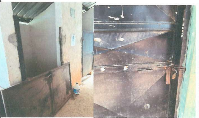
Foto 3: PUERTAS DE LOS BAÑOS Y LAS AULAS DE LA ESCUELA OFICIAL RURAL MIXTA CASERÍO EL AGUACATE, EN DETERIORO, SE NECESITA REPARACIÓN DE DICHAS PUERTAS PARA LA PRIVACIDAD DE LOS ALUMNOS Y MAESTROS, Y SOBRE TODO LA SEGURIDAD DE LOS MATERIALES QUE SE UTILIZAN EN LA ESCUELA PARA EL DESARROLLO DEL APRENDIZAJE DE LOS ALUMNOS
